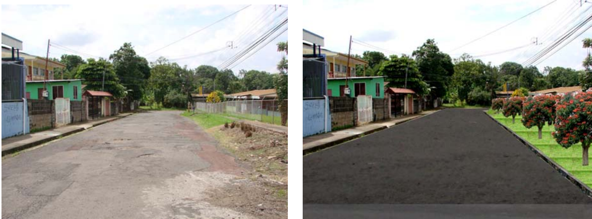
Fig. 34. La fotografía muestra el estado del área propuesta para las obras de tratamiento paisajístico urbano frente a la UNED, Orotina, Alajuela, 2008.
