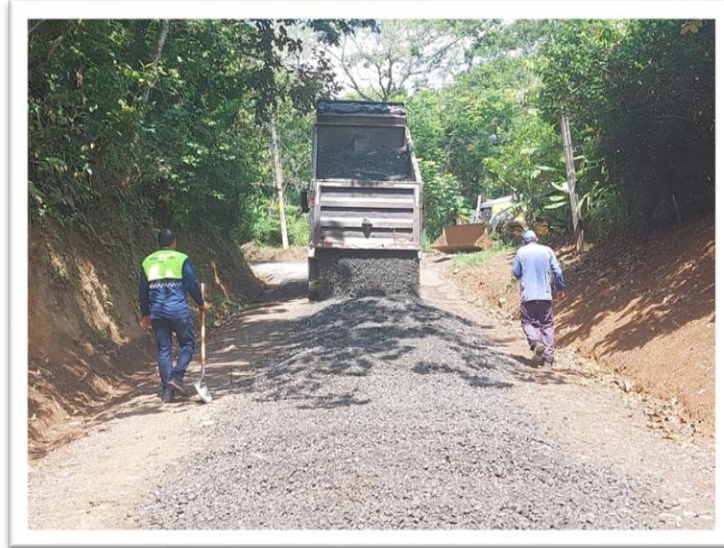
Figura 40 – intervención en proceso calle la esperanza (mayo)
