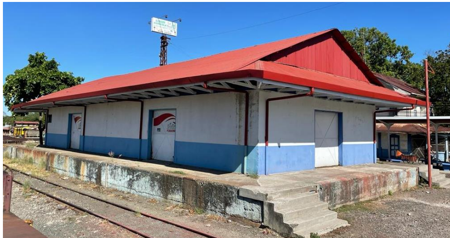
Fotografía 24. Bodega del ferrocarril.
