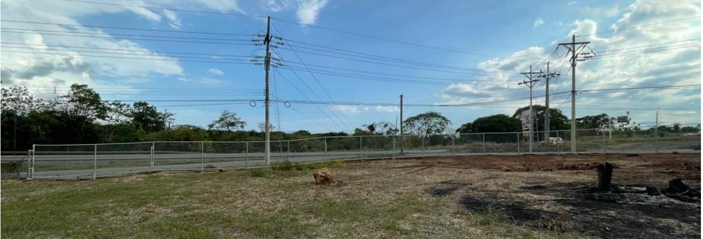
Fotografía 08. Instalación malla ciclón salón Uvita.
