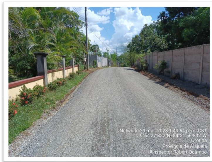
Figura 15- Trabajos finales del sector 2-09-020 calle aledaña al CTP
