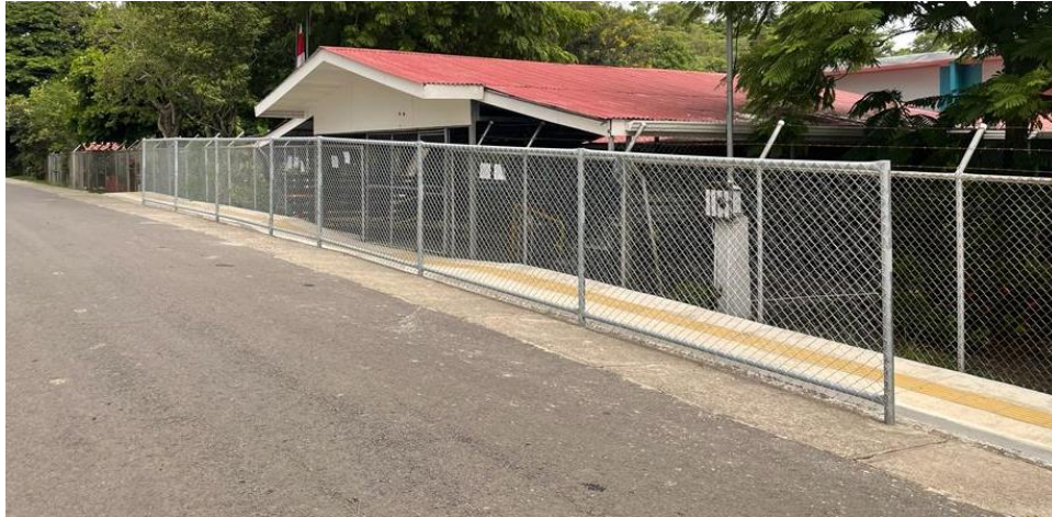
Fotografía 05. Malla y acera escuela Nueva Santa Rita.
