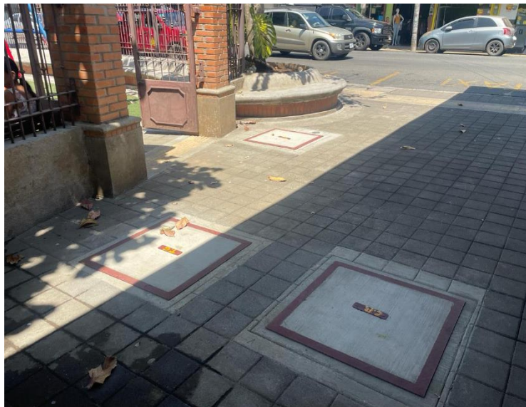
Fotografía 31. Mejoramiento sistema aguas residuales.
