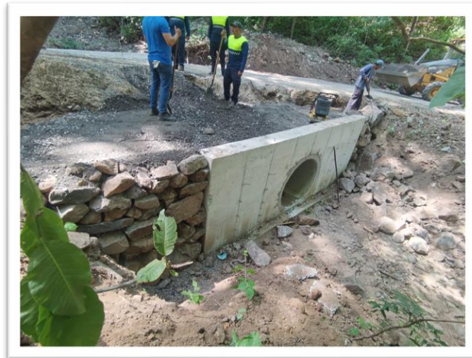
Figura 26- Refuerzo de pasos de alcantarilla sector Dantas
