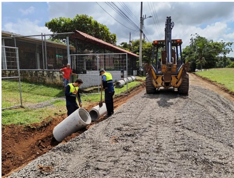
Figura 30 – Colocación de alcantarillado sector Vivero
