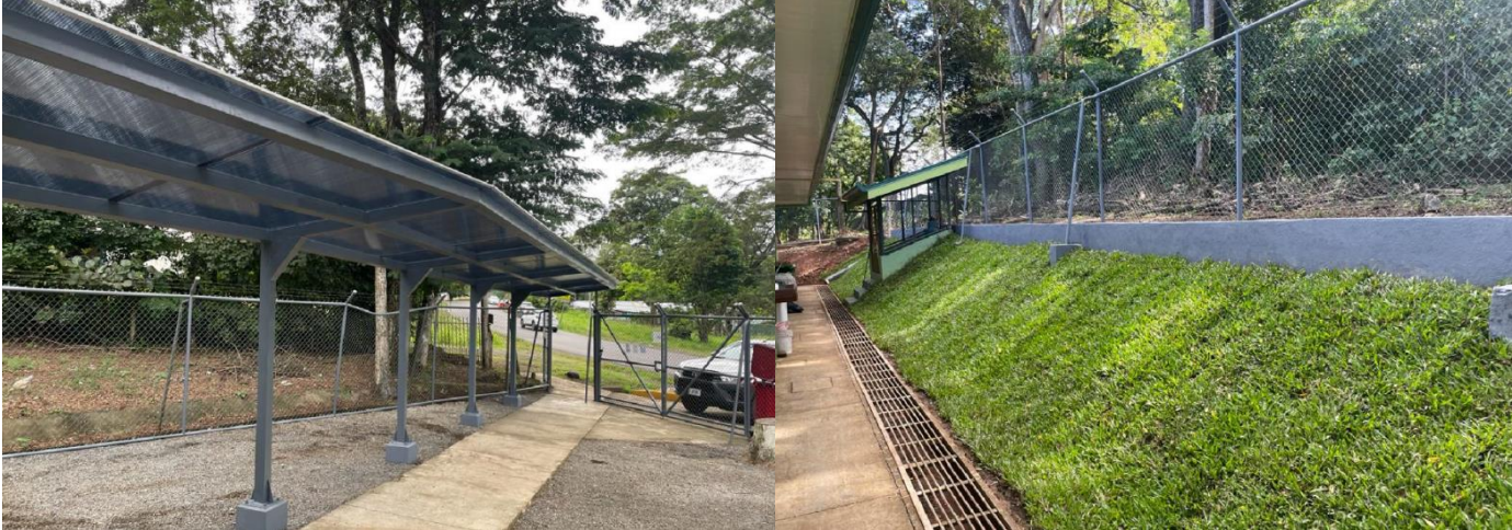
Fotografía 20. Muro y pasillo CECUDI.
