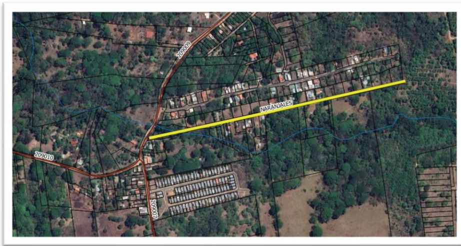
Figura 19 – Sector intervenido Proyecto Administración Naranjales,
