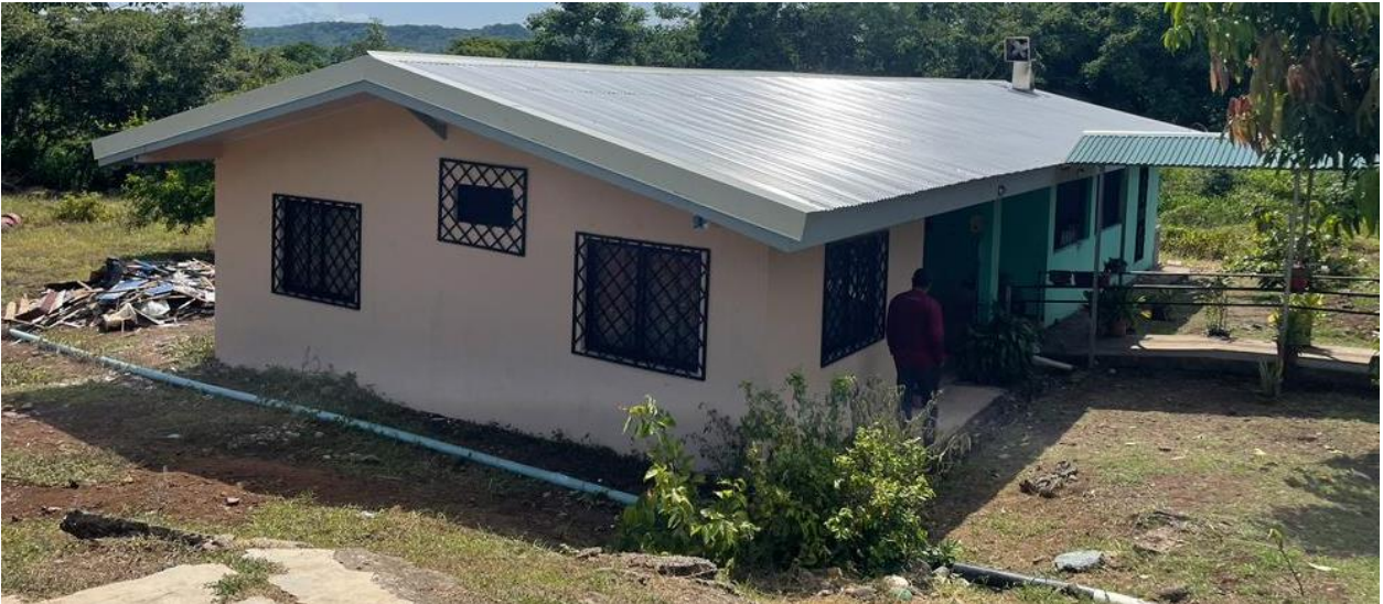
Fotografía 10. Cambio cubierta techo comedor IDA Salinas.
