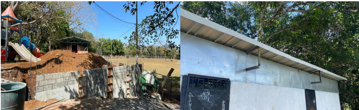
Fotografía 16. Mejoras plaza de deportes Mastate.
