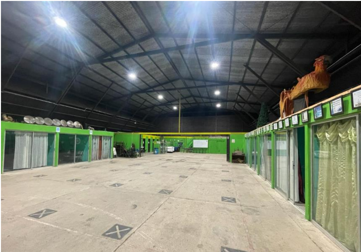
Fotografía 17. Mejoras plaza de deportes Mastate.
