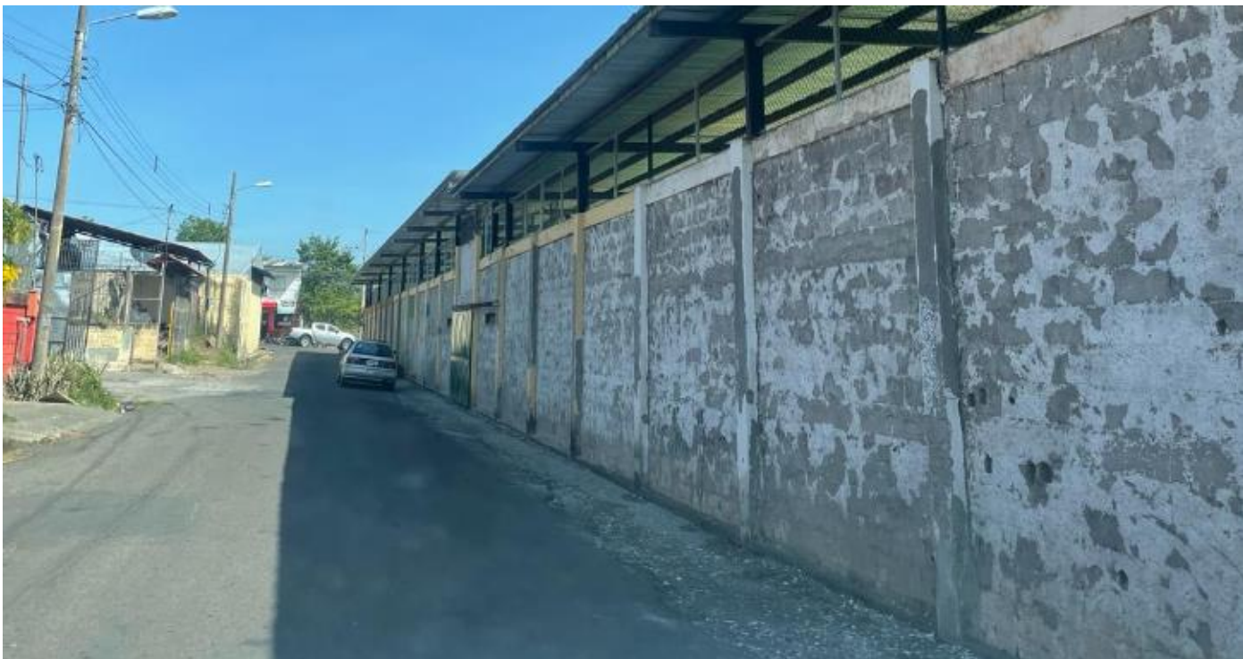
Fotografía 33. Remoción de repello dañado.
