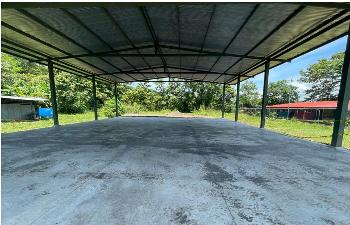
Fotografía 35. Contrapiso escuela Nueva Santa Rita.
