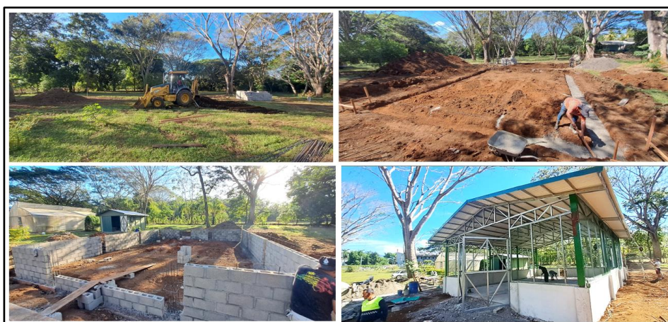
Fotografía 1: Construcción de galerón para tratamiento de residuos orgánicos 2023.
