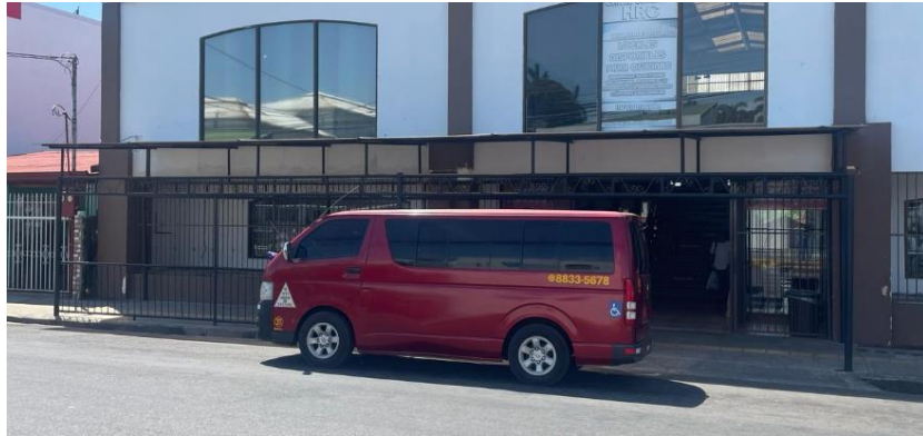
Fotografía 21. Muro y pasillo CECUDI.
