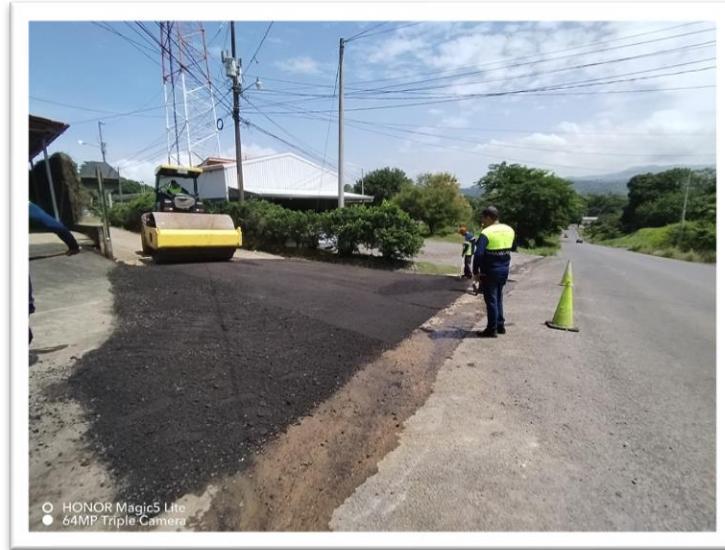
Figura 34- Colocación de perfilado sector Barrio Nuevo
