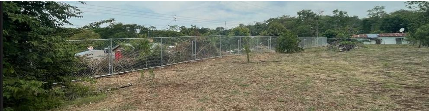
Fotografía 09. Instalación malla ciclón escuela La Uvita.
