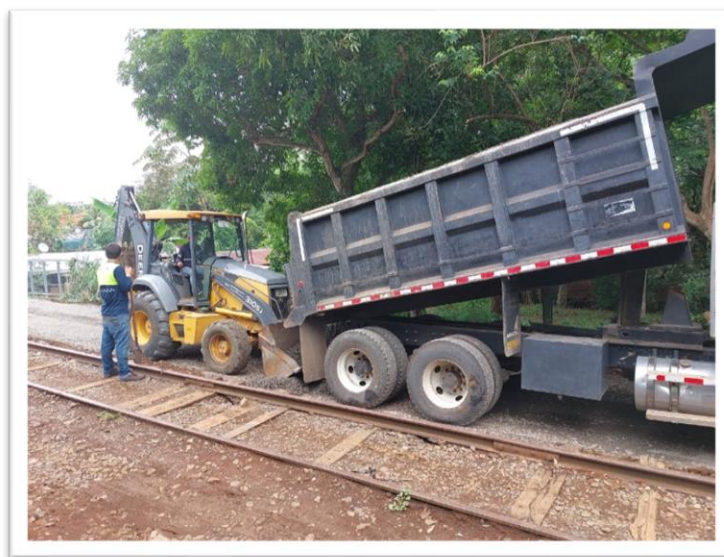
Figura 37 – Estado Previo de km2 proyecto Administración
