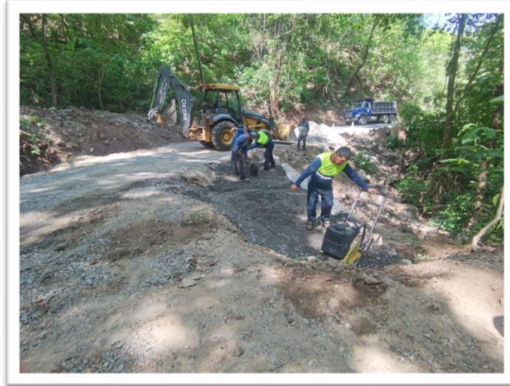
Figura 27- Uso de plancha compactadora para la compactación del material.
