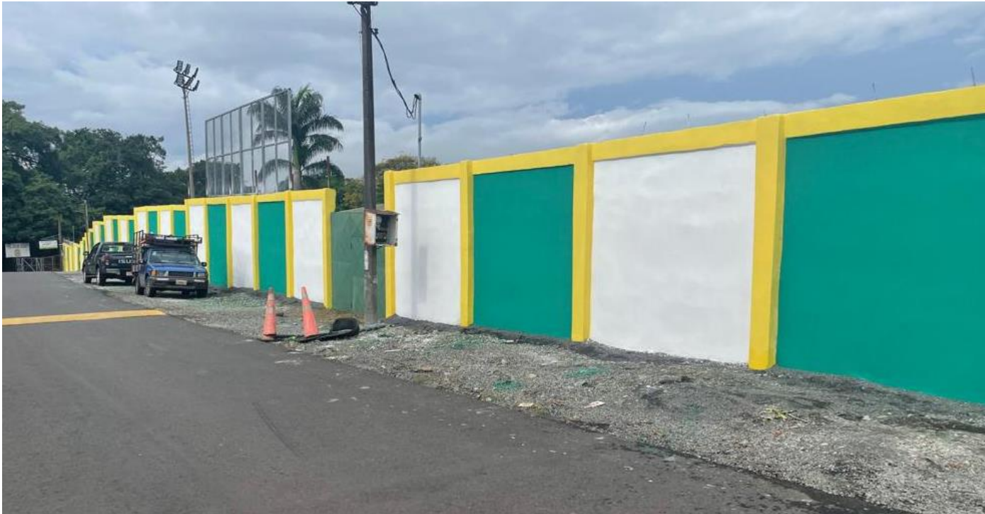
Fotografía 32. Repello y pintura paredes este del estadio.
