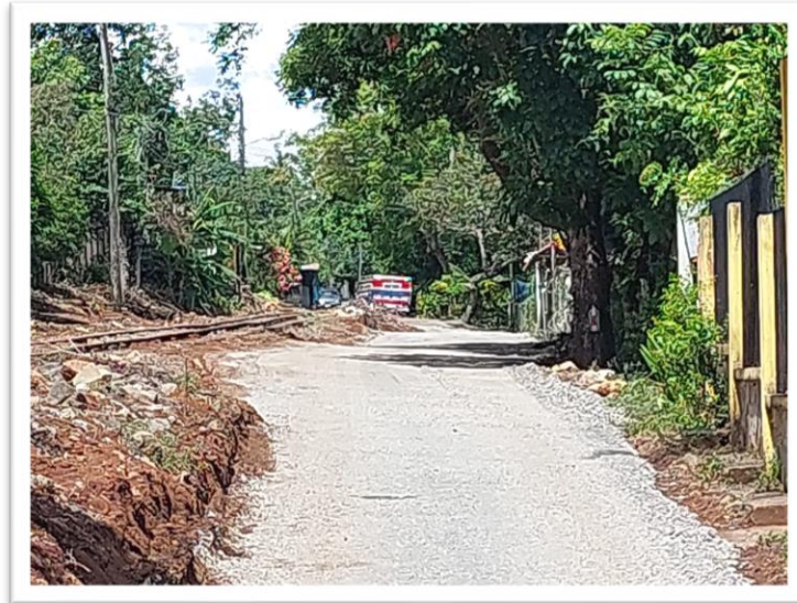
Figura 38 – intervención km2 administración
