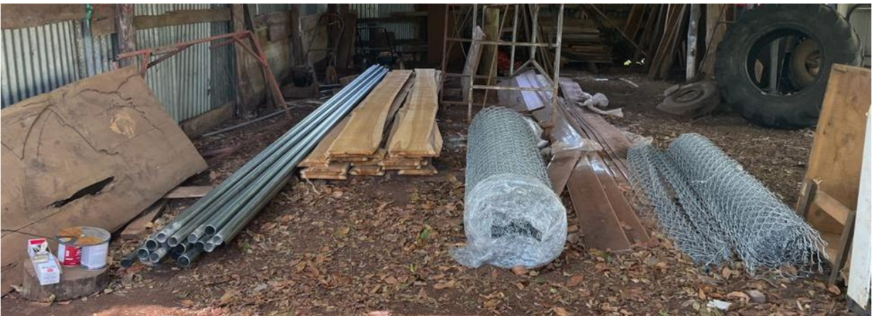
Fotografía 11. Materiales para la malla de la plaza de deportes.
