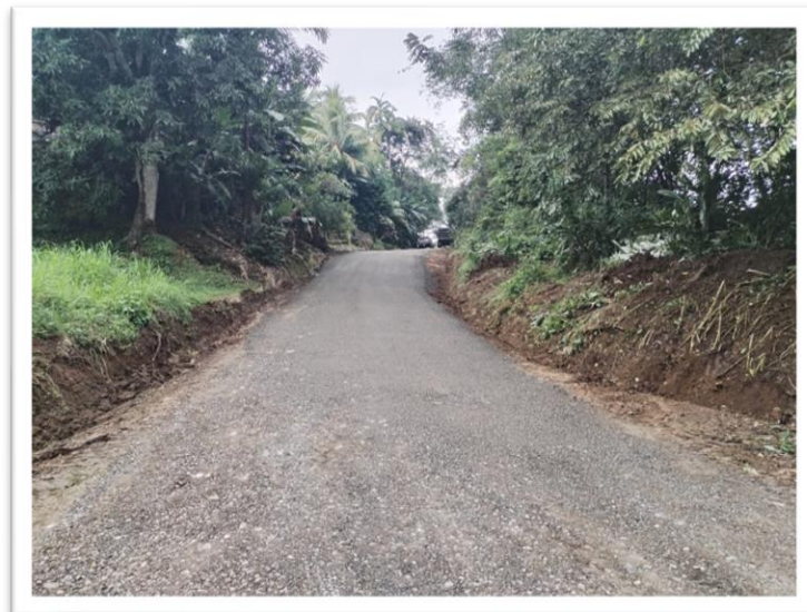
Figura 35 – intervención de Calle Vieja con perfilado.
